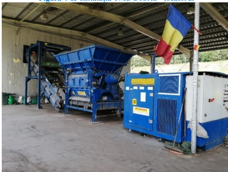
Figura 4-13 Instalația TMB Dobrin - tocătorul
