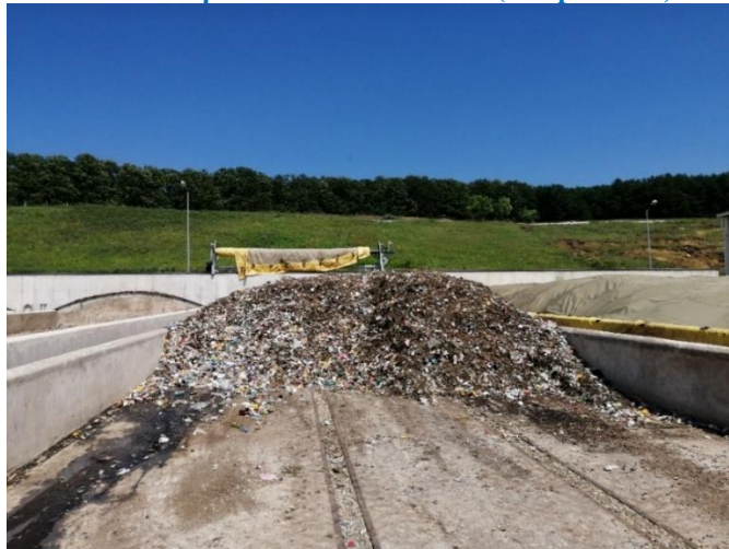
Figura 4-15 Platforma pentru tratarea aerobă (compostarea) a deșeurilor
