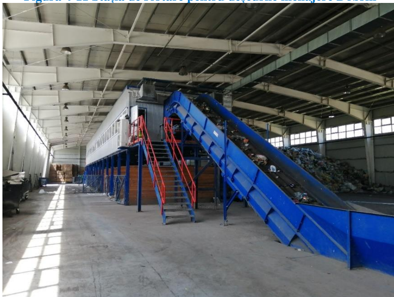
Figura 4-11 Stația de sortare pentru deșeurile menajere Dobrin
