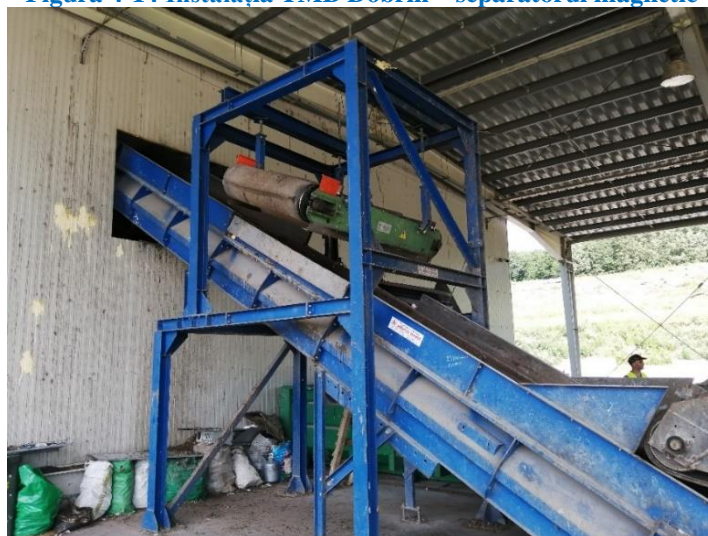
Figura 4-14 Instalația TMB Dobrin – separatorul magnetic
